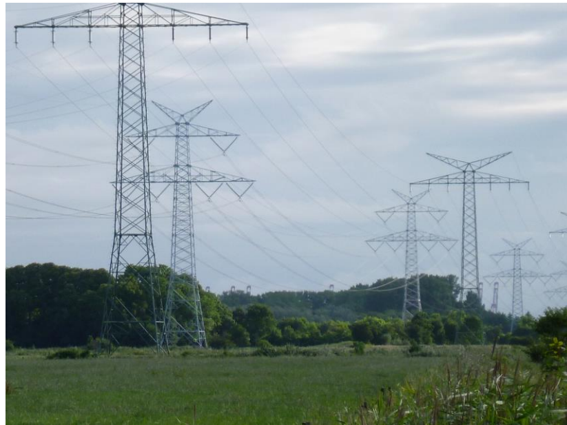
Freileitungen bei Hohewerth (11.08.2013, Foto: G. von der Mühlen)
