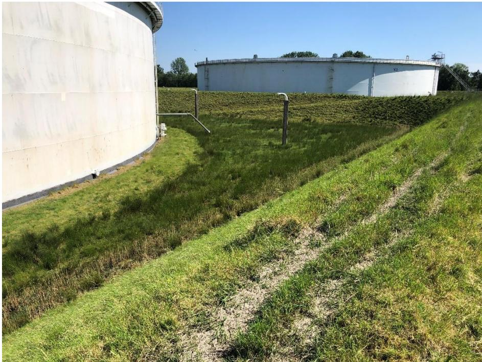
**Abbildung 15: Tankauffangraum im Südostteil des Tanklagers mit typischem Bewuchs**
