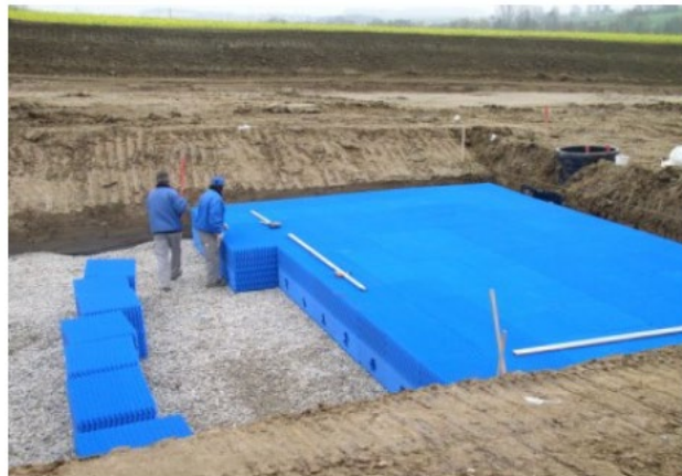
Bau einer Füllkörperrigole (Foto: Sieker)
